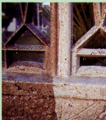
Struttura cementizia trattata e non sotto l'acqua
