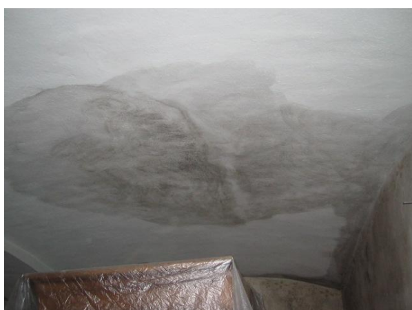
Camere del primo piano , evidenti gli aloni lasciati dalle muffe
