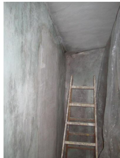
Camere del primo piano , evidenti gli aloni lasciati dalle muffe
