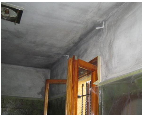
Bagno del primo piano , evidenti gli aloni lasciati dalle muffe
