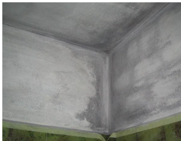
Bagno del primo piano , evidenti gli aloni lasciati dalle muffe
