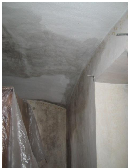
Camere del primo piano , evidenti gli aloni lasciati dalle muffe
