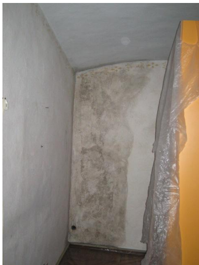
Camere del primo piano , evidenti gli aloni lasciati dalle muffe
